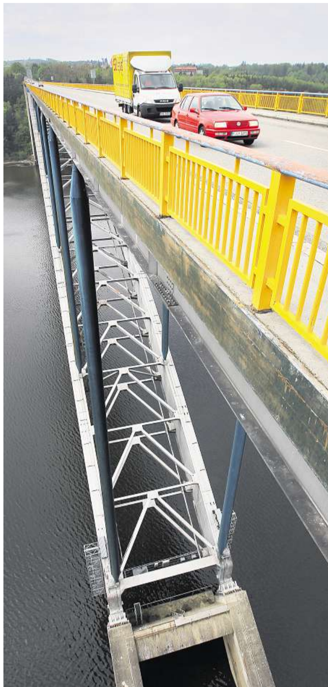
Rekonstrukce je nutná Žďákovský most bude 2 roky zavřený. „Takřka všechno půjde pryč, vyjma kovové konstrukce. Ta bude opískovaná a dostane protikoroziční ochranu,“ řekl Josef Pešl z ŘSD. Foto: L. Němec, MF DNES
