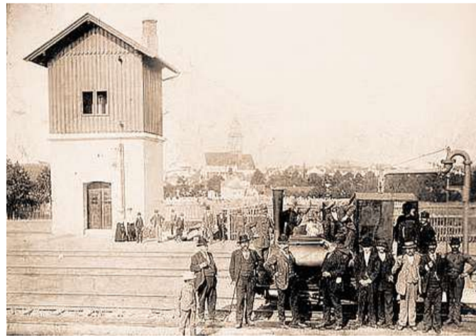
Snímek z roku 1902 Všechny vodárenské věže na trati z Kostelce do Slavonic byly budované okolo roku 1900. Foto: Archiv Miloše Fialy
