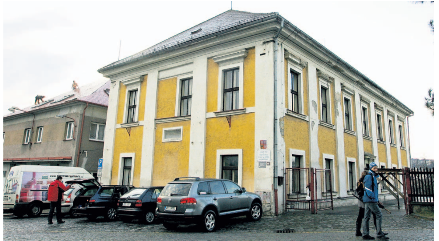
S chátráním je konec Budova rychnovské školy je v zoufalém stavu už mnoho let, teď by se konečně měla dočkat opravy. Foto: Jan Strouhal, MF DNES
