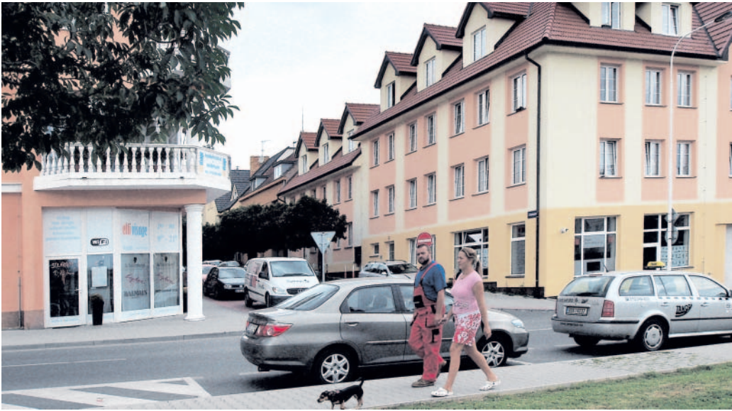
Současnost Zrekonstruovaná Ctiborova ulice v Kladně s opravenými domy. Od té původní s opráskanými budovami je téměř k nepoznání.
