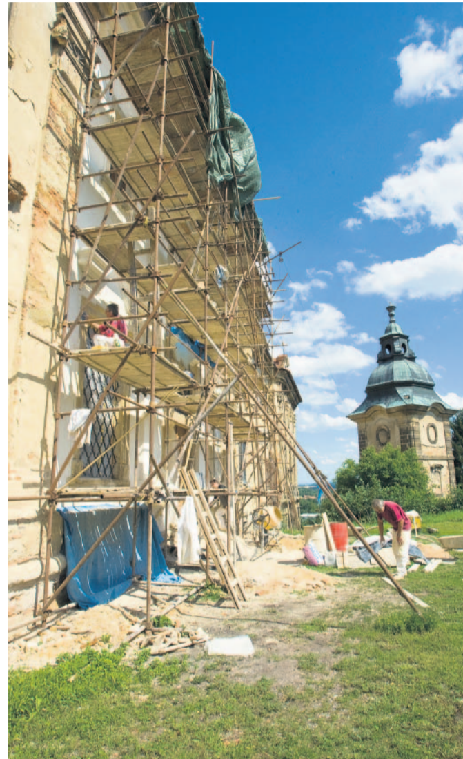
Prokoukne Jihozápadní křídlo kláštera bude mít novou fasádu. Restaurátorské práce jsou nyní v plném proudu. Foto: D. Beran, MF DNES
