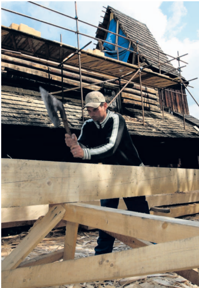
Mistr tesář Michal Vařák opracovává sekerou trámy sloužící k opravě dřevěného kostela. Foto: Alexandr Satinský, MF DNES
