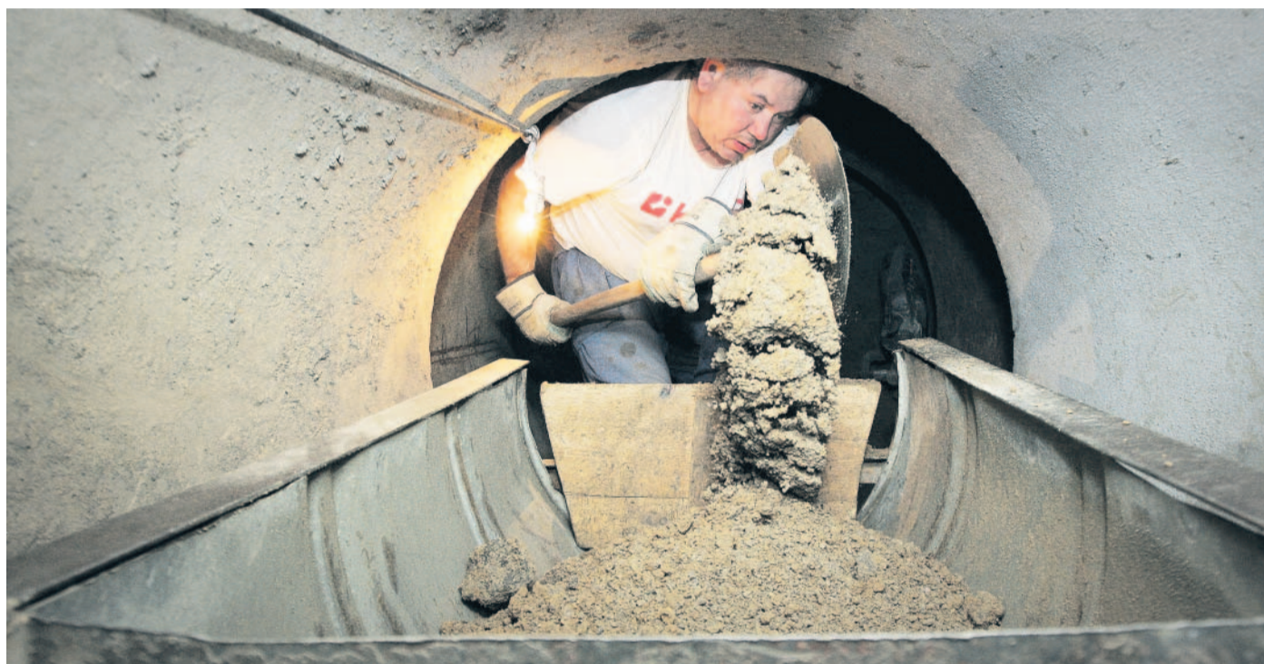
Potrubí Jedna štola pod Strakonickou ulicí v Budějovicích je hotová, nyní dělníci pracují na druhé.
