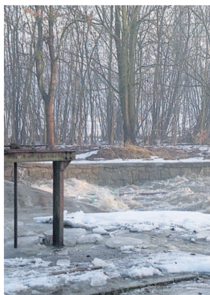
A zase ta voda Hladina řeky Úhlavy u plzeňského Hradiště stoupla (vpravo) vlivem deště a tání sněhu. Na řece platil ještě především první stupeň povodňové aktivity. Pod hradišským jezem (na horním snímku) se vytvořil obrovský válec prudce tekoucí vody.
