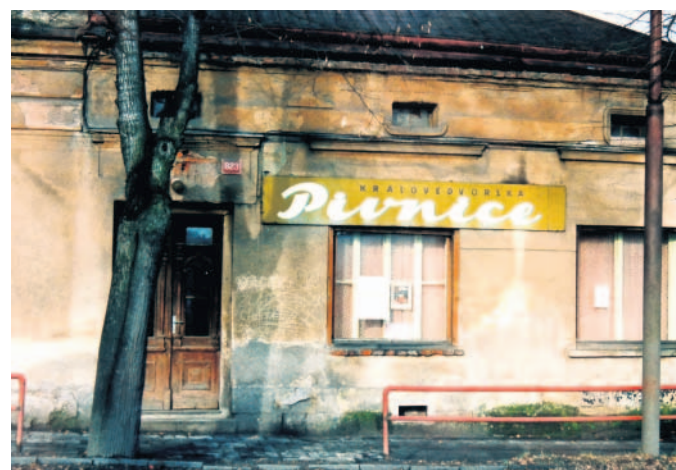
Po restituci v 90. letech byl hostinec v prachšpatném stavu.
