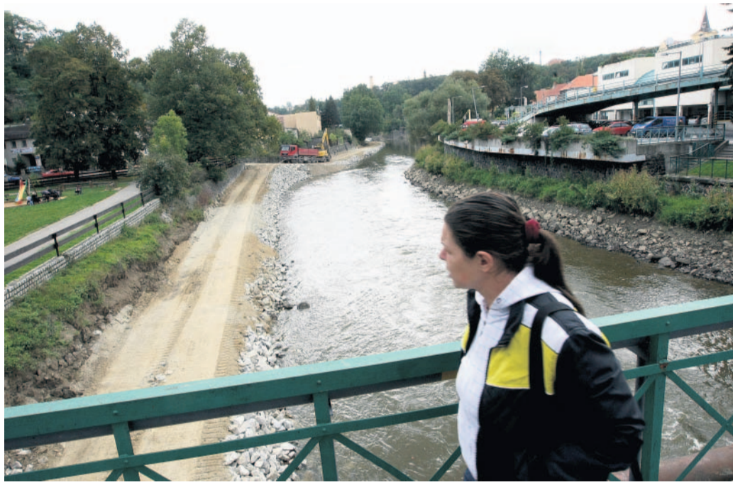
Ochrana Pracuje se i za trebičskou poštou a Billou.
