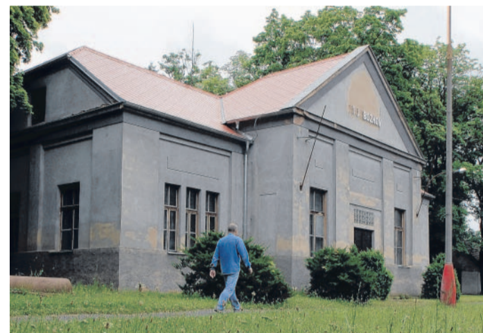
Dnešní stav V areálu stojí nepřilíhající udržovaná budova božkovské tělovýchovné jednoty.
