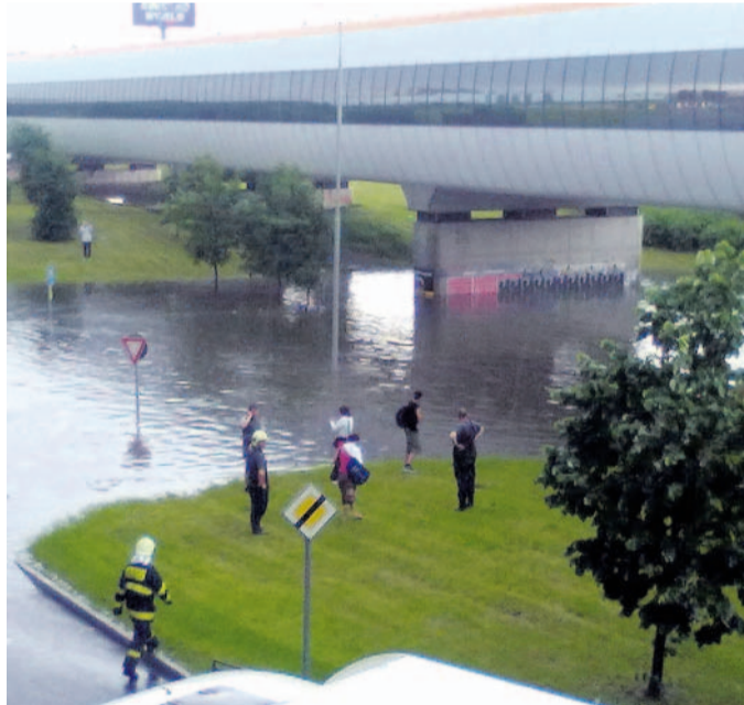
Pod přívalem vody byl také podjezd pod Chlumeckou ulicí na Černém Mostě.
