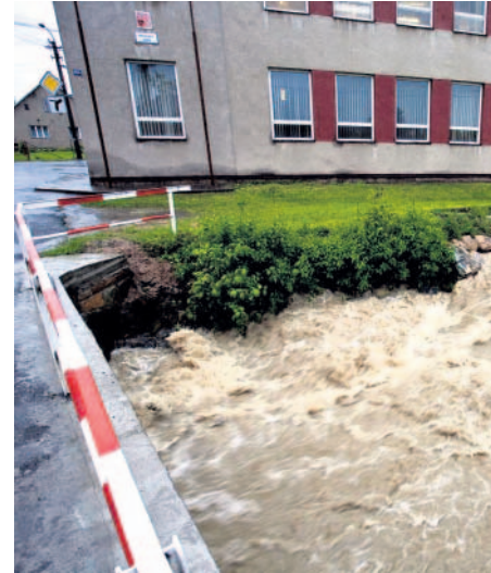
Před radnicí Voda se hnala městem. Z malé říčky byl rázem silný tok. Na snímku je vidět rozbořená řeka před tamním městským úřadem.
